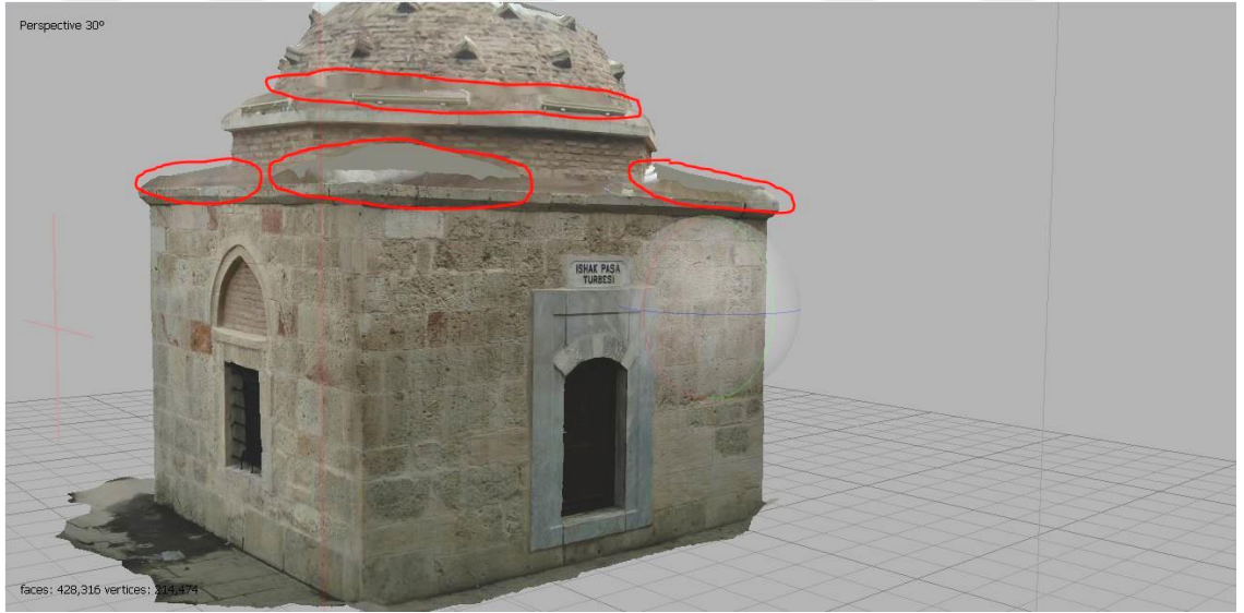
Şekil 33. Agisoft Metashape – 3B dijital model üzerinde bozulmaların işaretlenmesi
